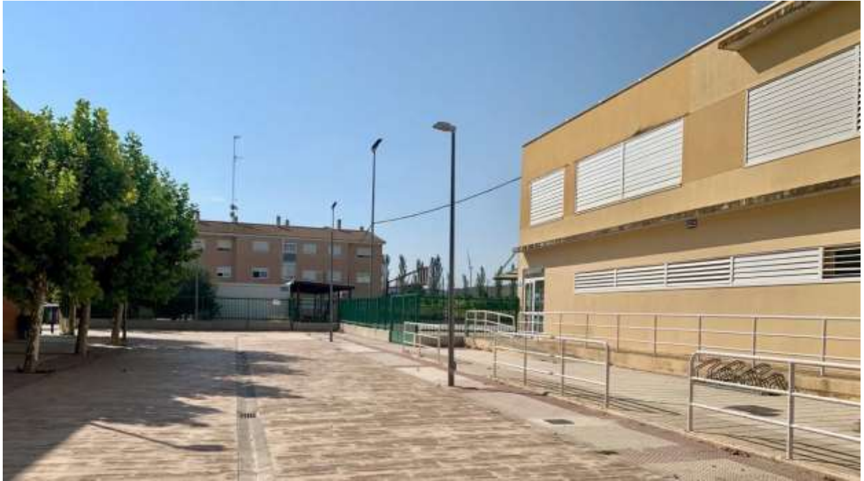
Emplazamiento general. A la izquierda el edificio principal destinado a Educación Primaria y al fondo, el terreno destinado al nuevo edificio para Educación Secundaria Obligatoria.
