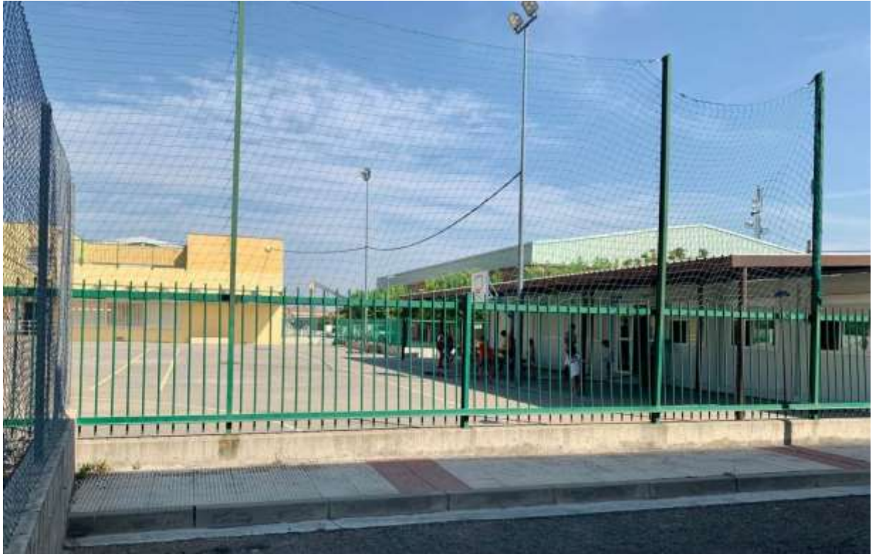
Vista desde el lado opuesto: vallado del recinto escolar y, en el interior, el patio de recreo
